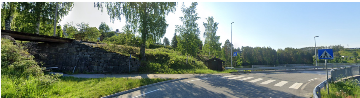
Figur 17 Eksisterende kryssingspunkt ved Krøderbrua
