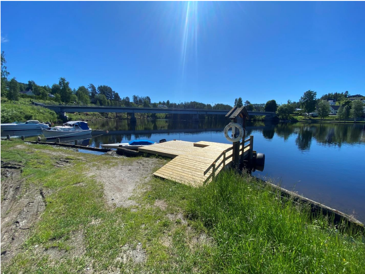
Figur 8-6. Eksisterende båtbrygge og båtplasser Krøderparken øst. Foto: Sweco Norge.
