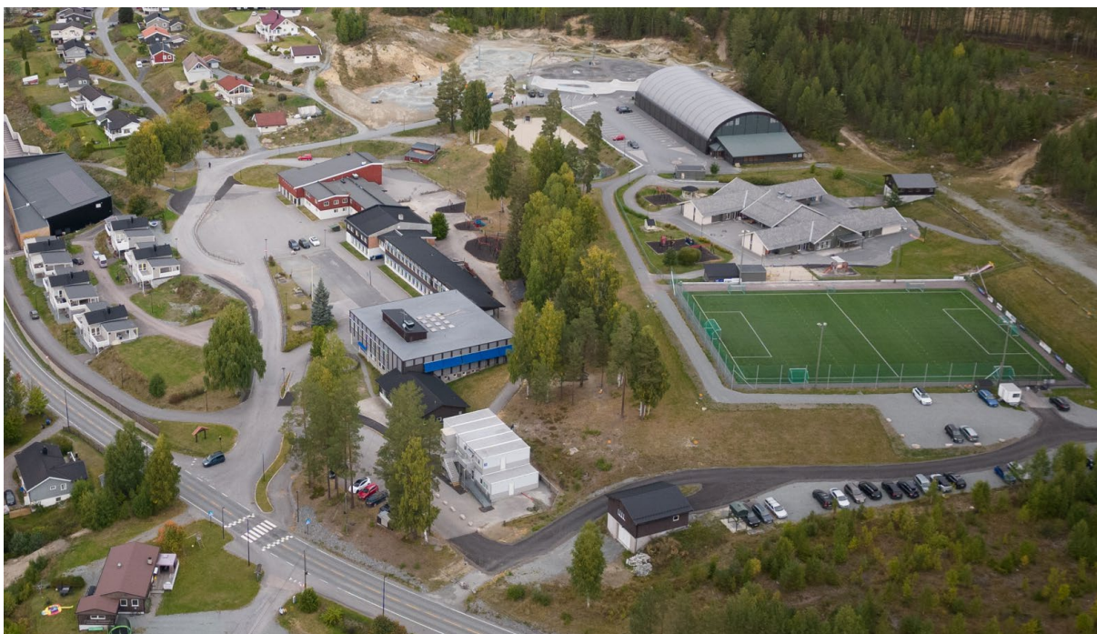
Figur 38. Bildet viser avkjøring fra fv. 280 til vegen Byåsen og skoleområdet (Dronefoto: DRMA).
