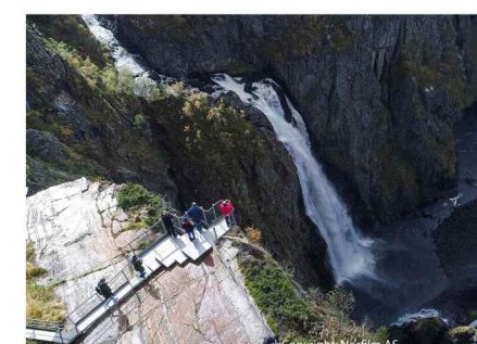
Nivåer i trappeforløpet tilpasses underlaget
