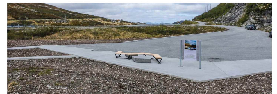
Overgang mellom asfalt grus og betong
