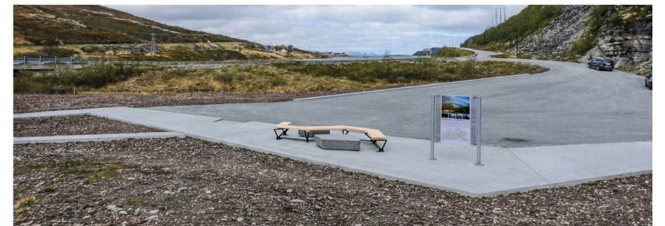
Overgang mellom asfalt grus og betong
