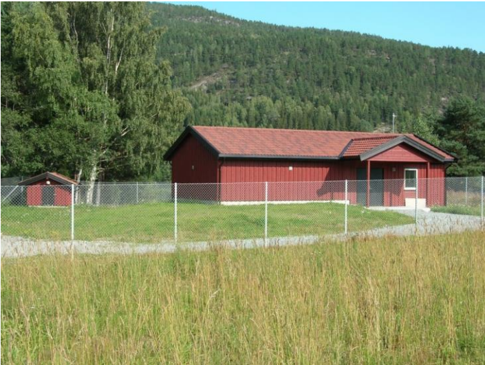
Figur 7-4: Bilde av Sunnelykkja VBA ved Noresund
