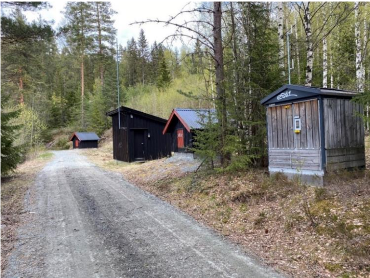
Figur 7-3: Grunnvannsbrønner Slettemoen (brønnoverbygg og trafo)
