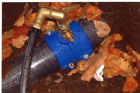
Figur 2-8: Bildet viser anboring på en vannledning.
