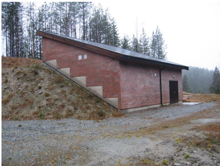
Figur 7-7: Bilde av bygget med luftebasseng - Slettemoen VBA (2014)
