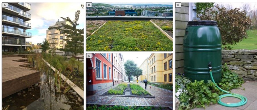
Figur 2-3: A: Åpen overvannshåndtering kan bidra estetiske kvaliteter gjennom permanente vannspeil (Foto: Kim H Paus). B: Grønne tak med liten veksttybde bidrar til at mindre regn fanges opp og fordampes (Foto: Bård Bredeesen / Naturarkivet). C: Regnbed i Deichmansgate bidrar til at mindre regn infiltreres, fordampes og forurenset avrenning renses (Foto: Åse Holte). D: Oppsamling i regntønner er et eksempel på å bruke vannet som ressurs (Foto: Buffalo Niagara Riverkeeper).
