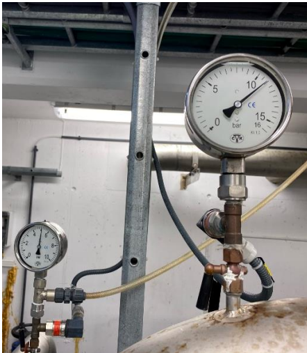
Figur 7-5: Godkjenning av Sunnelykkja VBA, og manometer som viser pumpetrykk mot hhv. HB21 Klokarplassen (5 bar) og HB Heia (11 bar)
