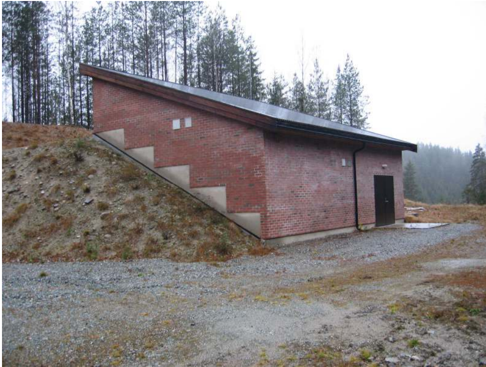
Figur 7-7: Bilde av bygget med luftebasseng - Slettemoen VBA (2014)
