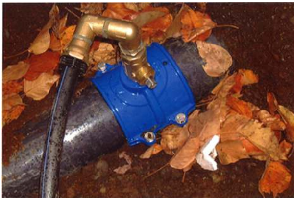
Figur 2-8: Bildet viser an boring på en vannledning.
