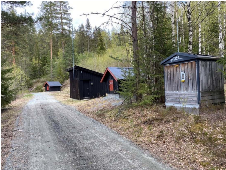
Figur 7-3: Grunnvannsbrønner Slettemoen (brønnoverbygg og trafo)
