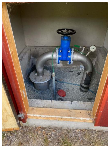
Figur 7-2: Grunnvannsbrønner ved Sunnelykkja VBA, og røropplegg i brønnoverbygg.
