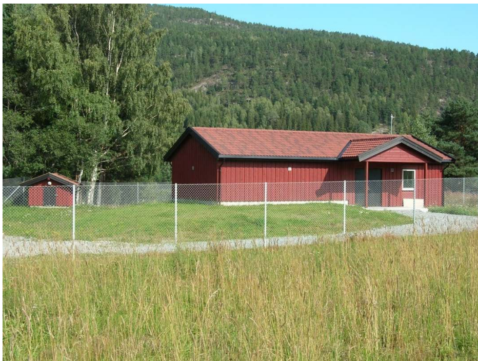
Figur 7-4: Bilde av Sunnelykkja VBA ved Noresund
