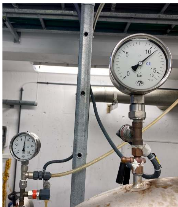
Figur 7-5: Godkjenning av Sunnelykkja VBA, og manometer som viser pumpetrykk mot hhv. HB21 Klokkarplassen (5 bar) og HB Heia (11 bar)
