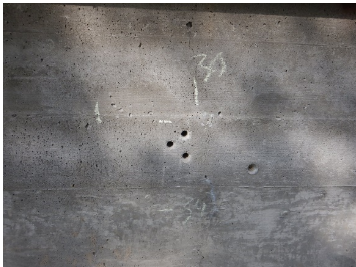
Bilde 21: P1 uttak av kloridprofil
