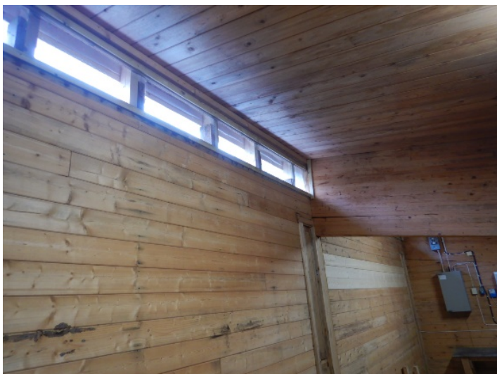
Bilde 14: Yttervegg langsido øst. Åpne luftespalter i øvre del. Kledning på utside byttet i 2020, innside er ikke skiftet i denne forbindelse.
