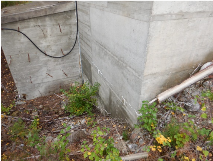
Bilde 3: Bassengvegg mot vest. ventil/teknisk rom
