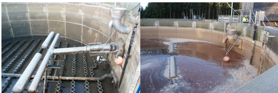
Figur 5: SBR-reaktor fra SBR-reaktor på Grødaland på Jæren. På det første bildet vises også luftesystemet i bunn samt dekanter-utakeren for renset avløpsvann.
