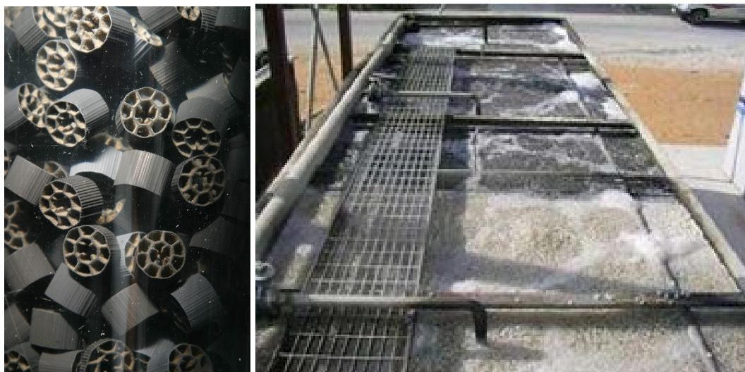
Figur 3: Illustrasjon av plastbærerne biomassen gror på, samt et åpent luftet basseng med MBBR
