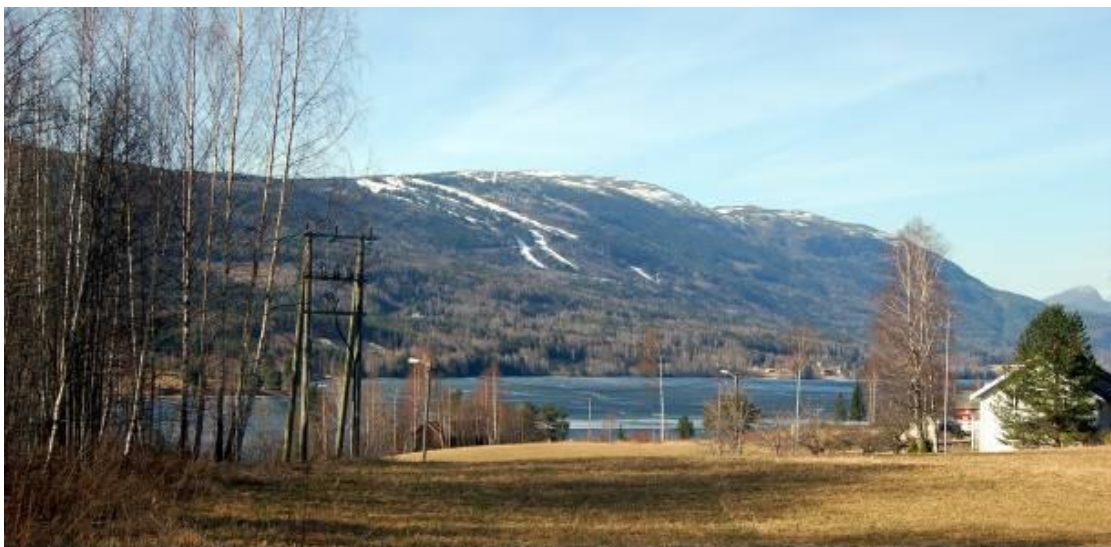
Figur 3-4 Planområdet nordre avgrensing vender seg mot dyrka mark og vestover mot Krøderen og Norefjell i bakgrunnen. Det er tenkt at fremtidig strømtilførsel sikers fra høyspenten som vises i bildet. Denne ligger om lag 40 meter fra regulert boligvei SKV4.
