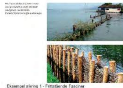
Eksempel sikring 1 - Frittstående Fasciner
