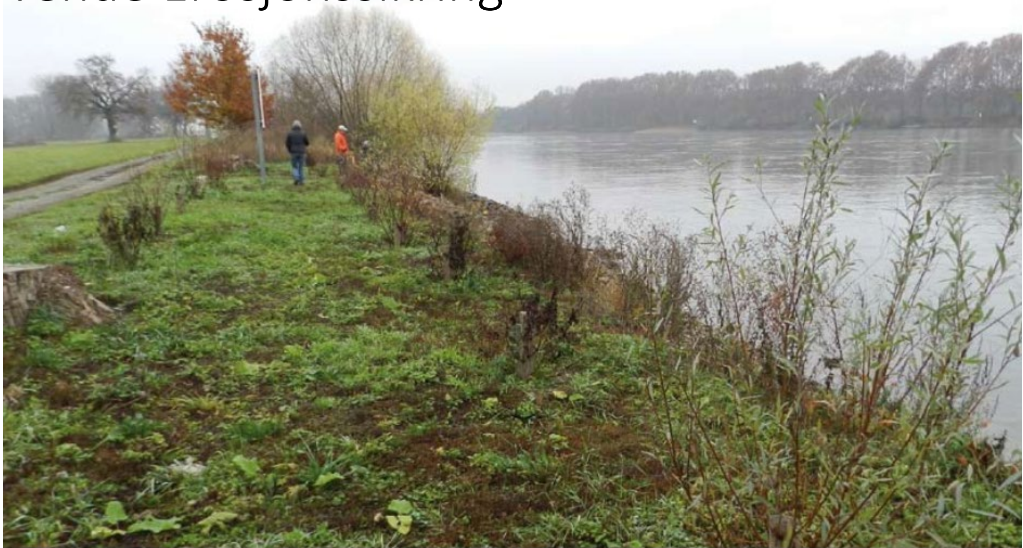
Abb. 2.36: Weidensetzstangen als schlafende Sicherung (Rhein bei Worms)
