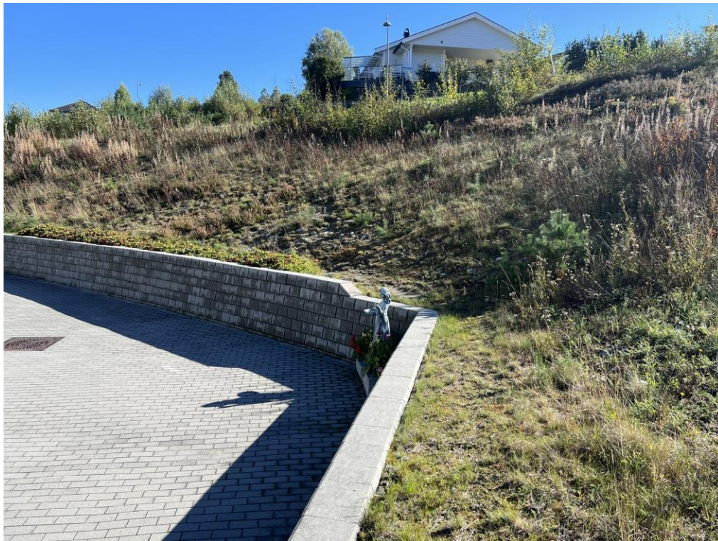
Figur 34: Foto viser kanten av muren, hvor steinleggingen befant seg før den ble fjernet.
