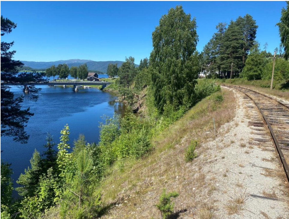
Figur 4-26. Krøderbanen med bru over utløpet av Krøderen i bakgrunnen. Bratt jernbanefylling med noe vegetasjon. Foto: Sweco Norge.
