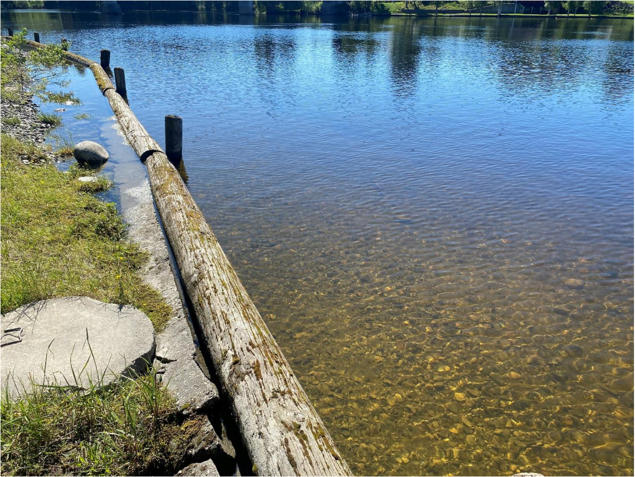
Figur 8-5. Eksisterende strandsone på nokså høy vannstand. Foto: Sweco Norge.
