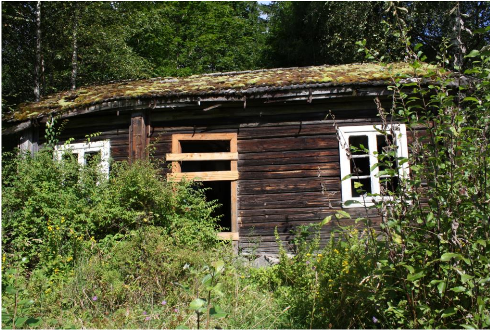
Framsiden mot kiløypa
