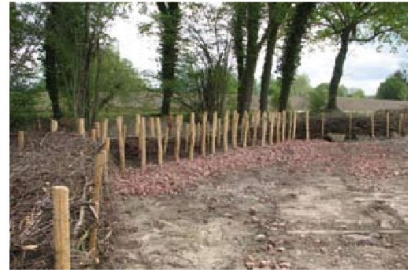
Abb. 2.40: Lahnung als Geschwemmselbstfang bei Deichrückverlegung, im Bau (Leopoldskanal bei Rheinhausen)
