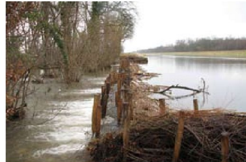
Abb. 2.41: Geschwemmselbstfang bei Hochwasser (Leopoldskanal bei Rheinhausen)
