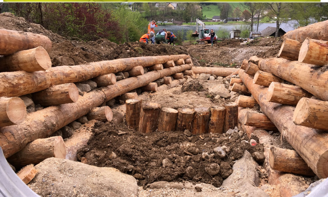
Bepflanzte Holzrainerwand doppelwandig
