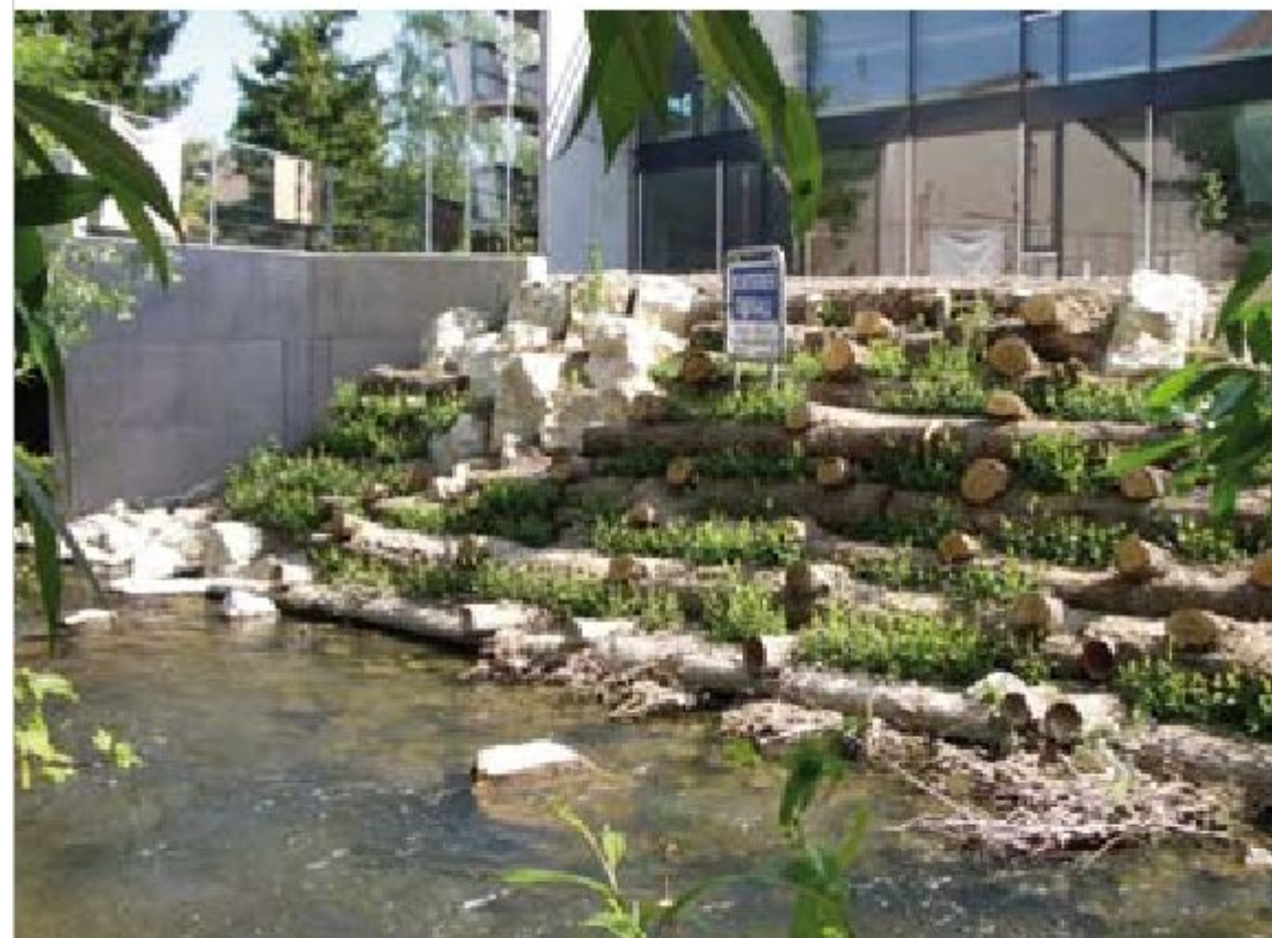
Abb. 2.14: Krainerwand und Steinsatz (Lauter in Kirchheim)
