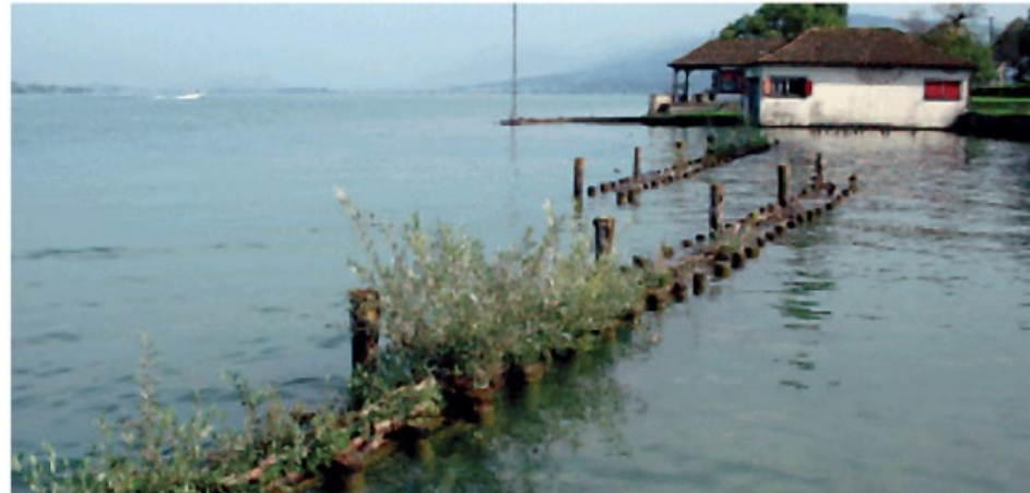
Abb. 2.40: Lahnung als Geschwemmselbstfang bei Deichrückverlegung, im Bau (Leopoldskanal bei Rheinhausen)
