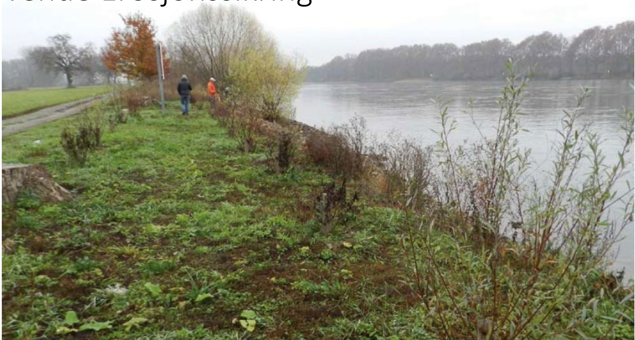
Abb. 2.36: Weidensetzstangen als schlafende Sicherung (Rhein bei Worms)
