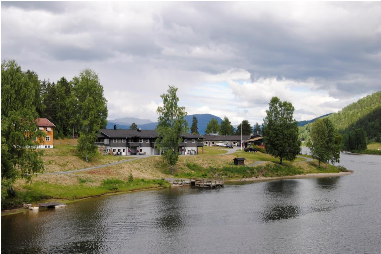
Kryllingheimen og omsorgsboliger, sett fra Noresund bru.
