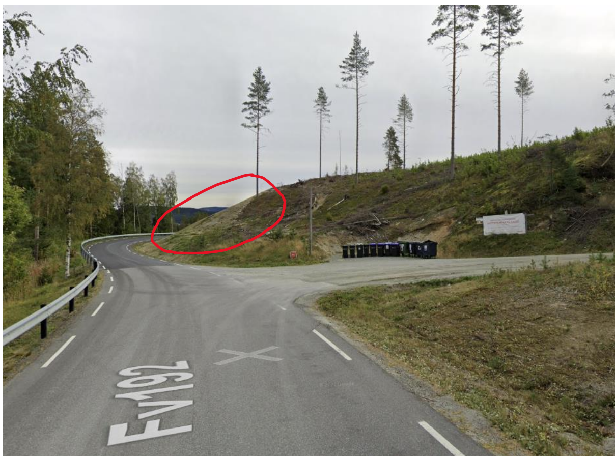
FIGUR 1: DAGENS ADKOMST FRA FV. 2896 VESTSIDEVEIEN X HOVDEVEIEN. RØD SIRKEL VISER HELLENDE TERRENG SOM ER TIL HINDER FOR NOE AV FRISIKTEN VED UTKJØRING FRA HOVDEVEIEN. UTKLIPP TATT FRA GOOGLE MAPS 15.01.23, MED DATO SEPTEMBER 2019.
