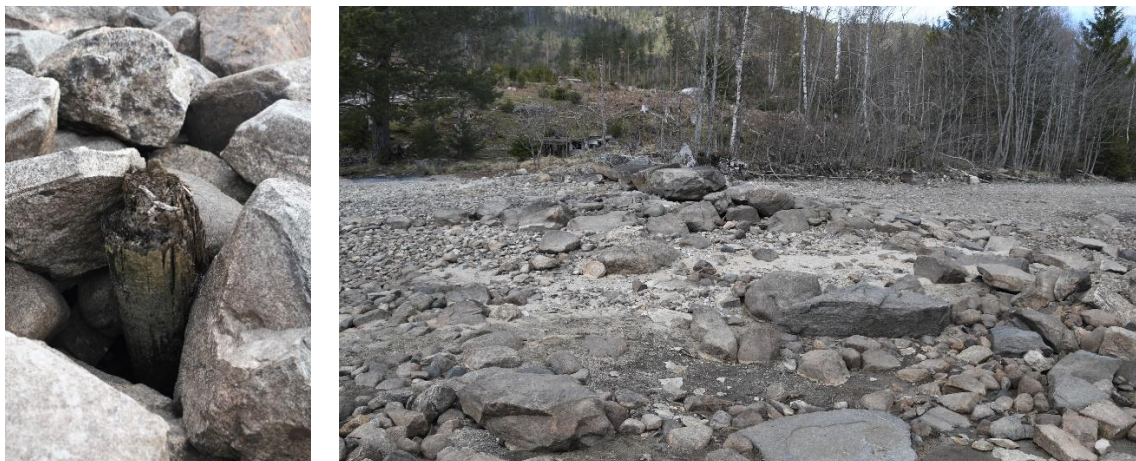
Figur 14 og 15. Foto 06.05.2021. Rester etter dampskipsbrygga.
